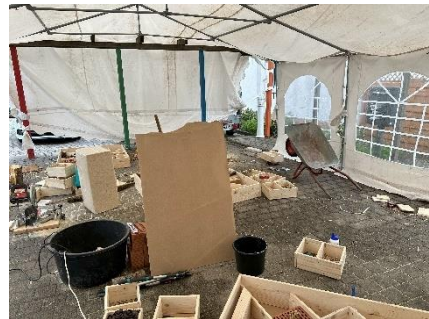
Baustelle vor dem Gemeindezentrum Maria Himmelfahrt ©Maria Himmelfahrt
